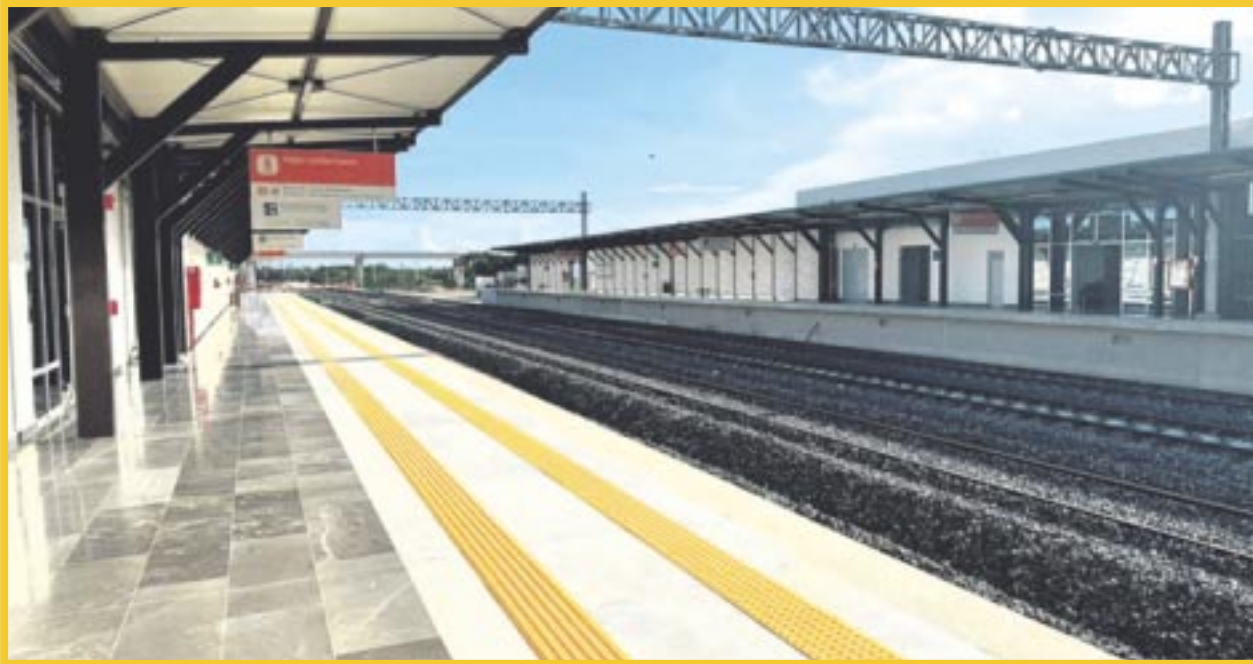
La estación Felipe Carrillo Puerto, parte del ambicioso proyecto del Tren Maya, está programada para iniciar operaciones el 20 de septiembre.
