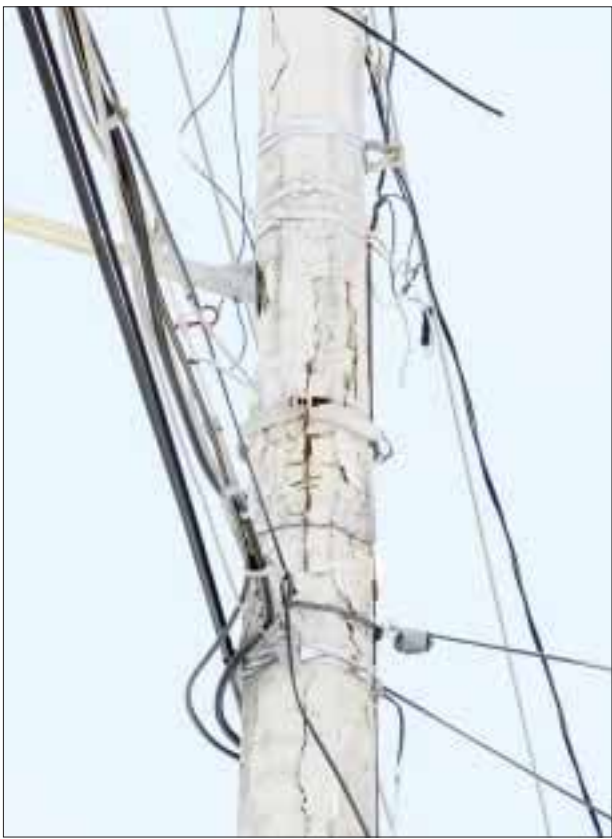
No sólo la base de los postes está dañada, también la parte superior, como se demuestra en esta gráfica.
