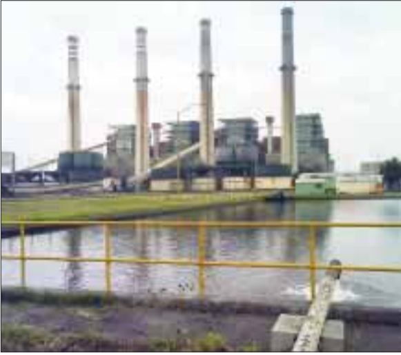
Planta carboeléctrica José López Portillo de la Comisión Federal de Electricidad.
