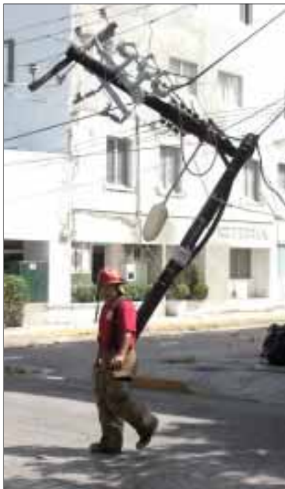
La explosión ocurrida en la azotea de la clínica privada Victoria, dejó daños por 800 mil pesos.
