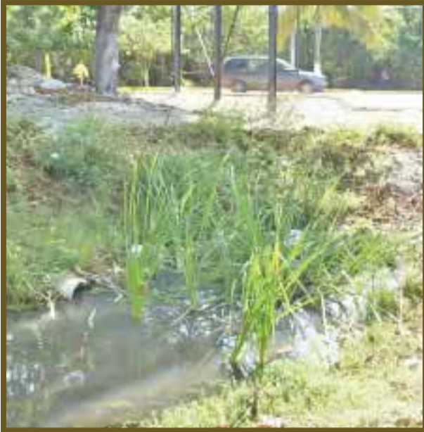
Dren de aguas negras a cielo abierto; los habitantes no aguantan la fetidez.
