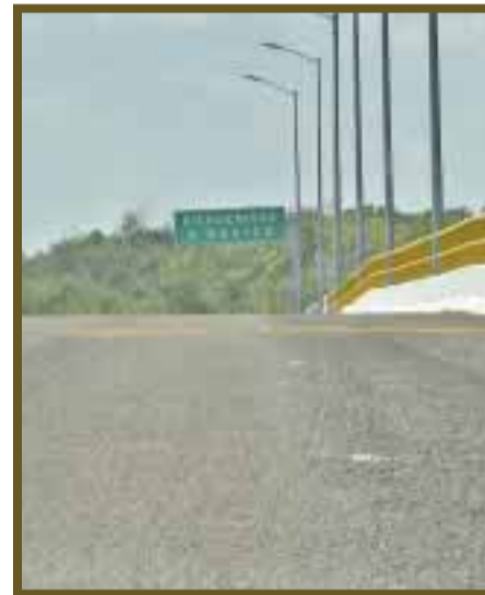
Carretera México-Belice, una de las obras realizadas por personal militar.
