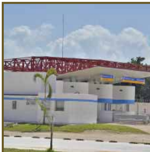
Caseta de control cuenta con los mejores equipos para no permitir cruces ilegales.
