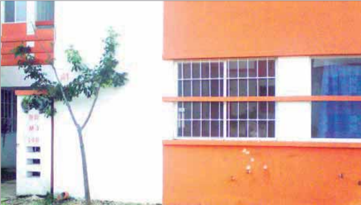
La casa baleada se ubica en el número 260 calle Chacté, manzana 3, lote 8, casa 48 "1" en el fraccionamiento Prado Norte.
