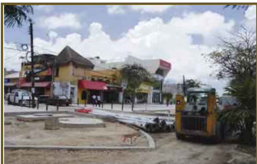
Trabajadores de obra pública.
