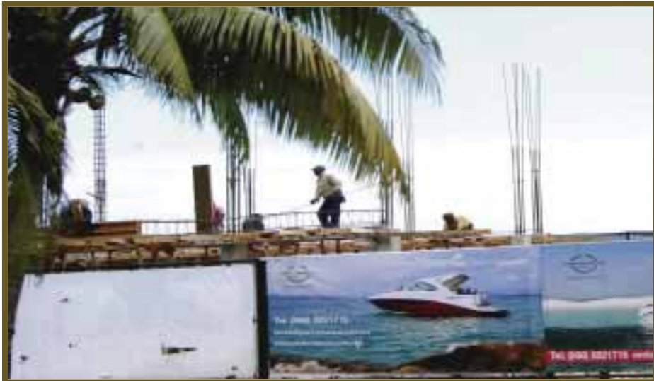
Albañiles, trabajando a pleno rayo del sol.
