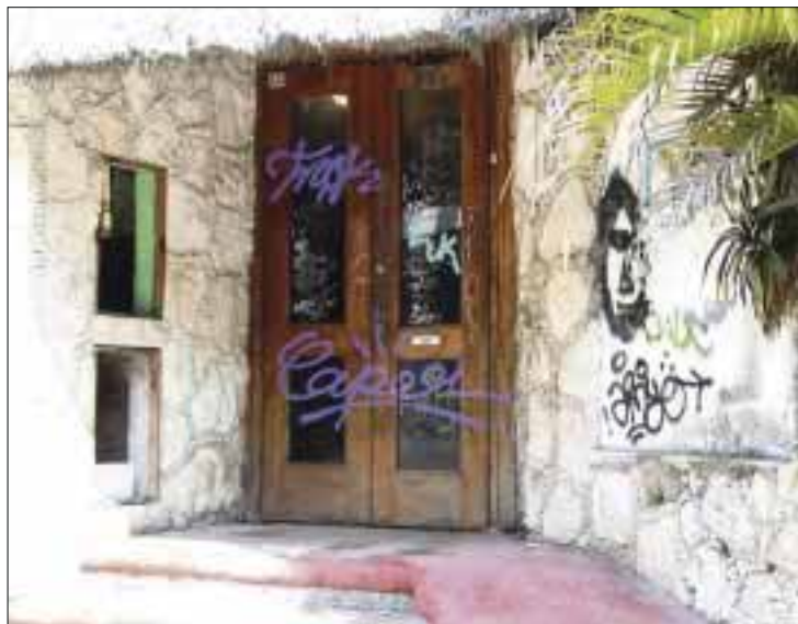
Este edificio se ubica a unas cuadras del palacio municipal fue reportado como un baño público y posada de vagos y malvivientes.
