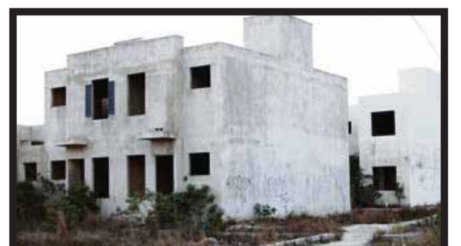
FRACCIONAMIENTOS COMO ANDALUCÍA, Villa Marino y Villas del Arte son invadidos ilegalmente.
