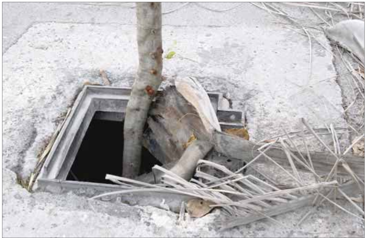
Una colección de baches se han formado sobre la avenida Leona Vicario, en la esquina con avenida Lombardo Toledano.
