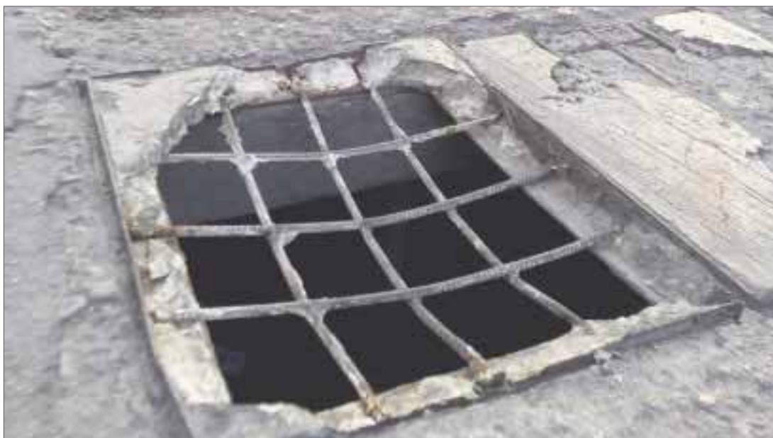
De esta forma se encuentran la alcantarilla y el registro de Telmex en avenida Xcaret.
