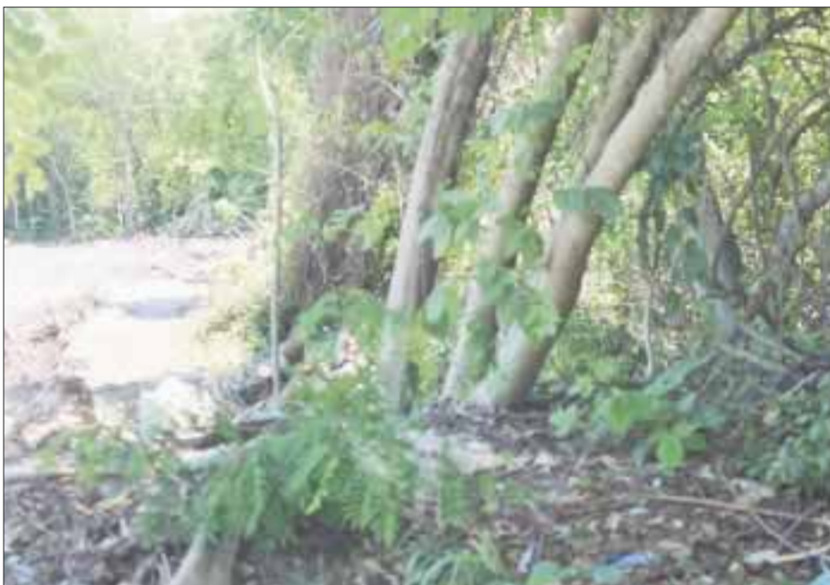
La construcción se encuentra en pleno boulevard Bahía, donde se utilizó maquinaria pesada para el desmonte.
