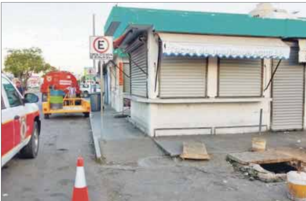
Concluyeron los trabajos en el drenaje del mercado Lázaro Cárdenas.
