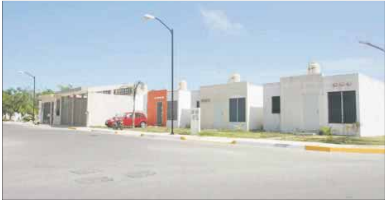
La falta de alumbrado en los fraccionamientos Villas del Mar y Villas Otoch son una zona peligrosa ante la falta de mantenimiento a las luminarias.
