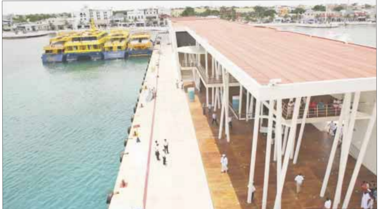
Desmantelan pasarelas que costaron 1.2 millones de euros y su destino final fue convertirlo en chatarra, de donde se recuperó en su venta 8 mil pesos.
