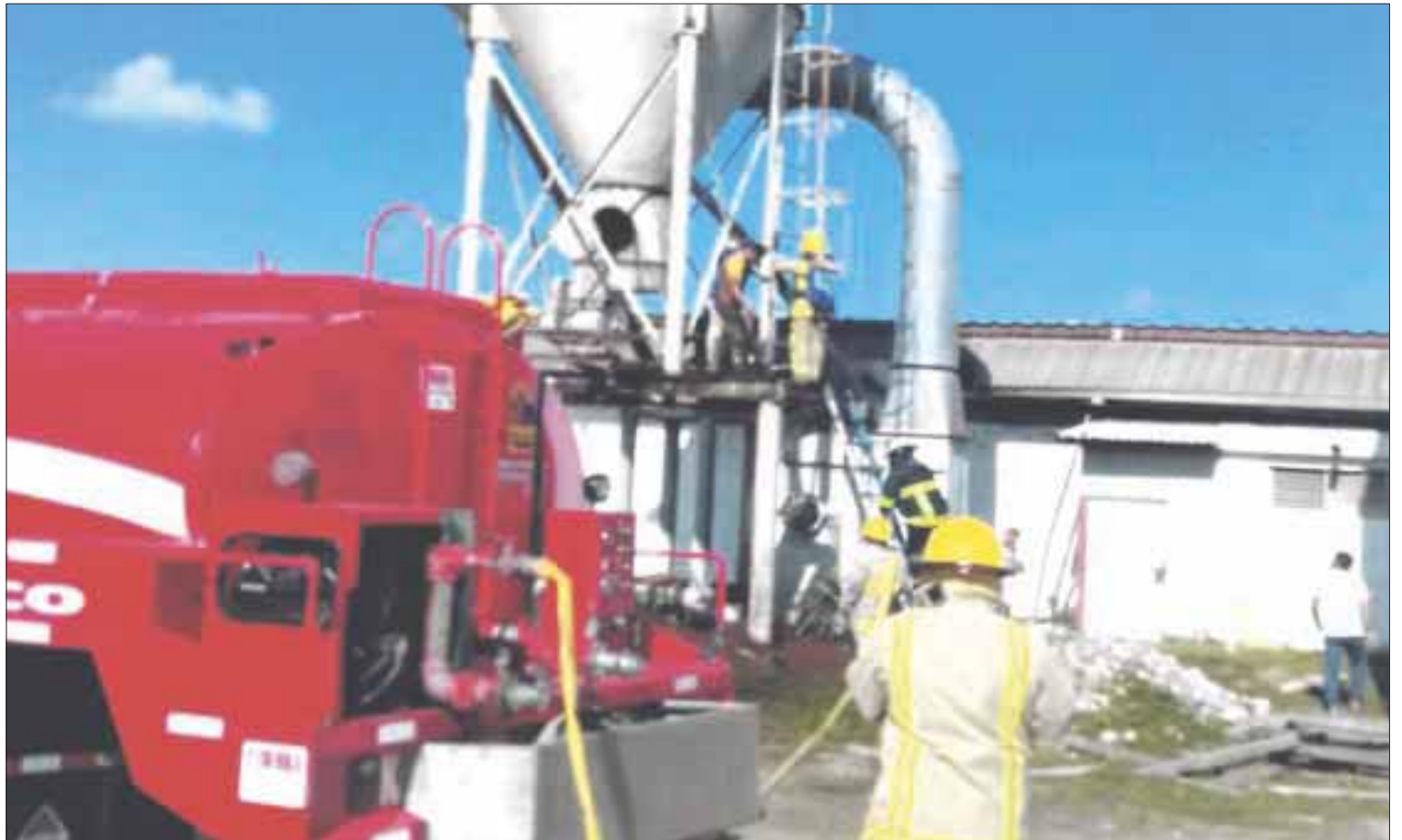
El incendio en la zona industrial de Chetumal movilizó al cuerpo de Bomberos.
