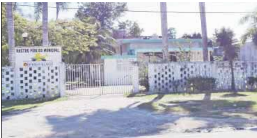
El ayuntamiento de Othón P. Blanco cerrará el actual rastro, sito frente al aeropuerto y espera se pongan en marcha las nuevas instalaciones tipo TIF en el parque industrial.
