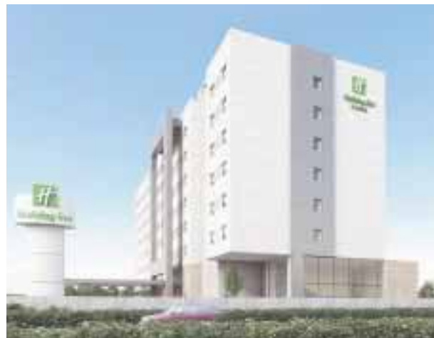
El nuevo hotel en Aguascalientes
