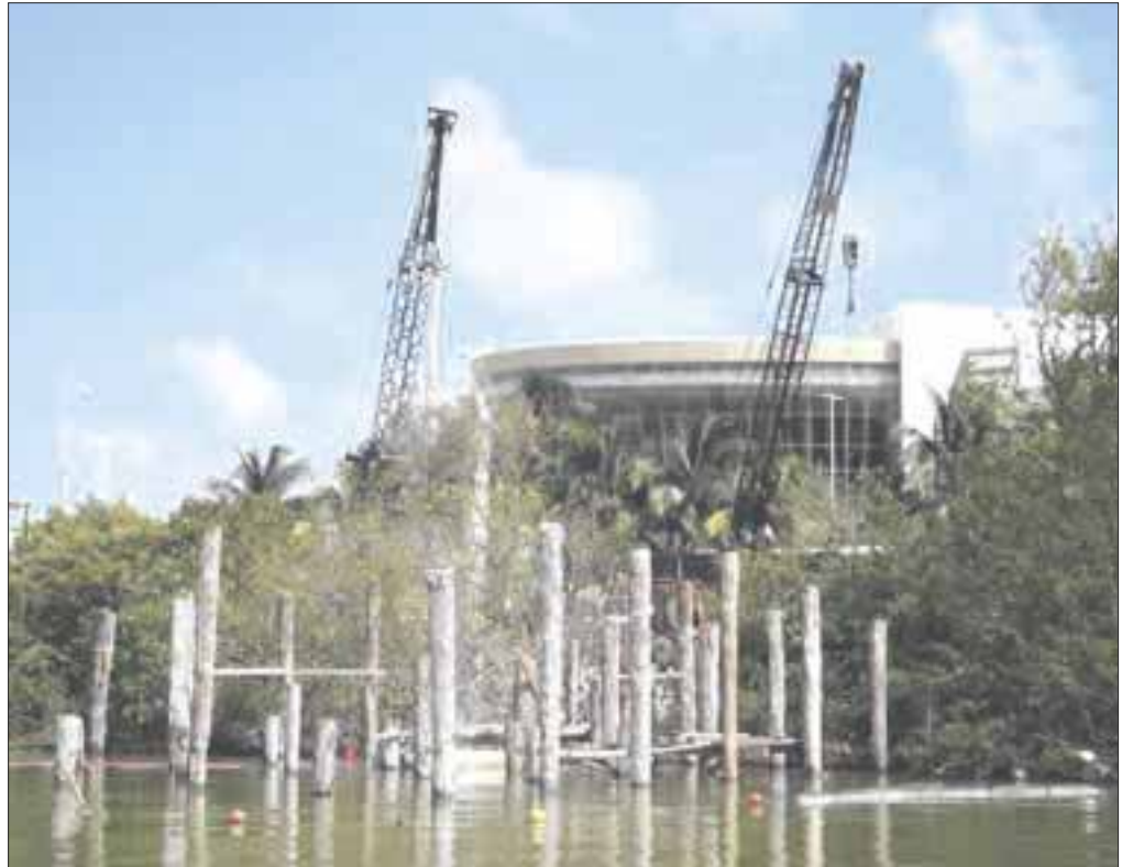
La primera obra se encuentra en el kilómetro 12.5 de la zona hotelera, en un predio que se encuentra al lado del restaurante Green Bay.
