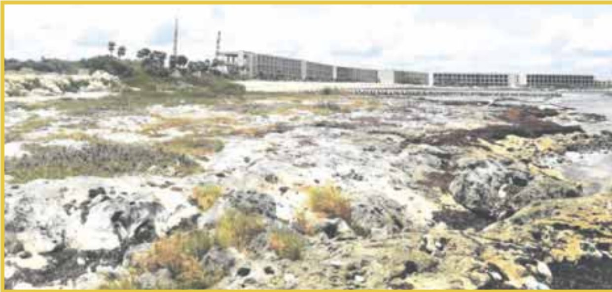
La playa artificial que se construyó en la bahía de Chemuyil, dentro de las obras de un complejo hotelero, quedó completamente destruida.
