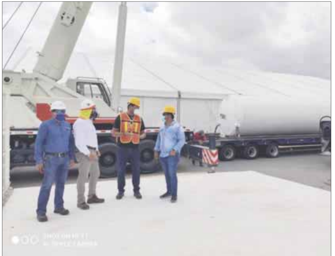
Se incrementa la reconversión de la infraestructura hospitalaria en Playa del Carmen y Cozumel.
