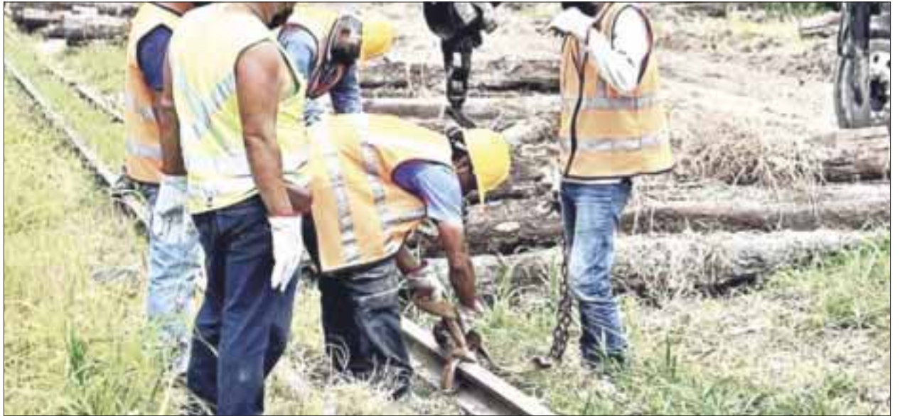
Fonatur informó que ya ha comenzado a comprar los rieles para los primeros cinco tramos del Tren Maya.
