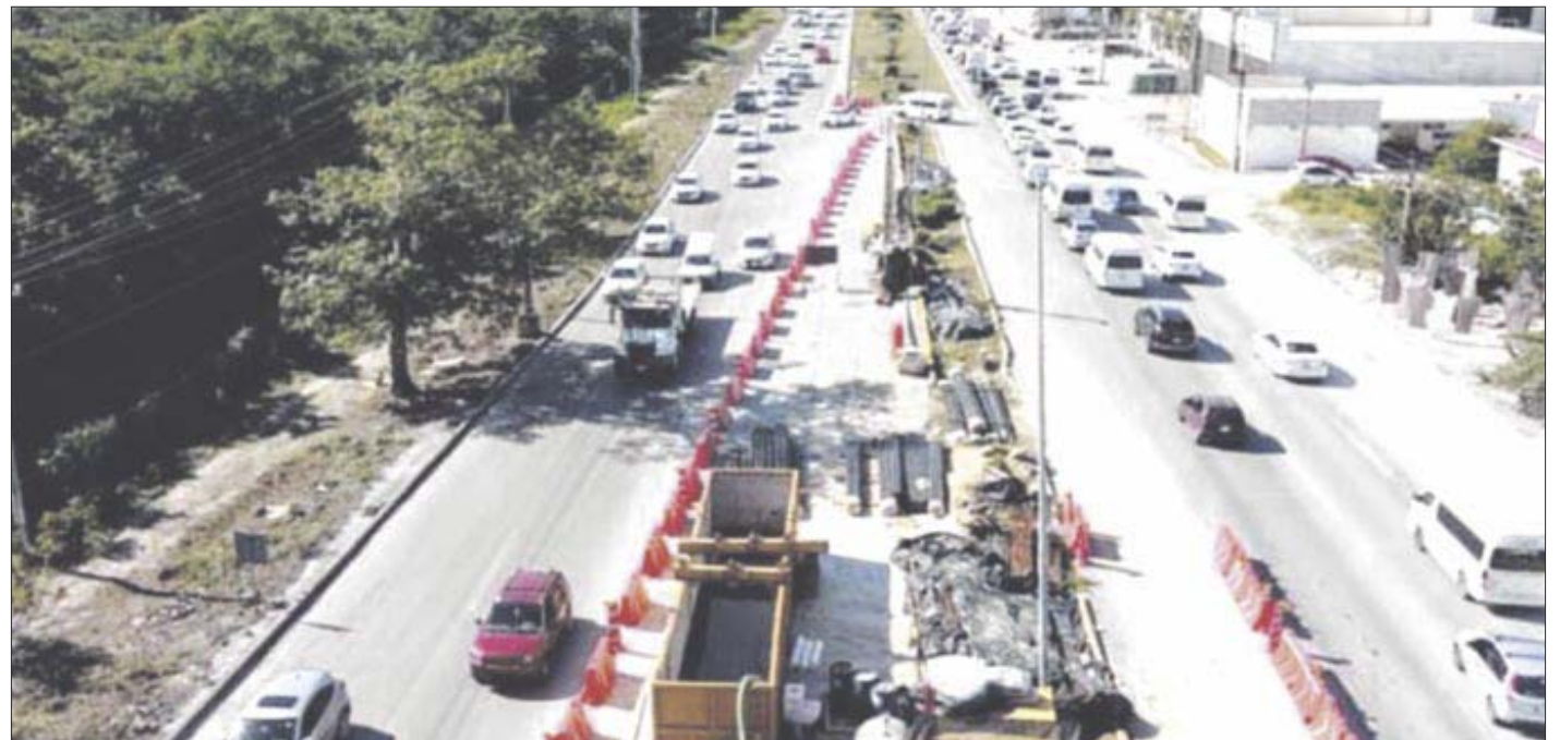
Obras del Tren Maya comienzan a generar estragos en el tema de la movilidad.
