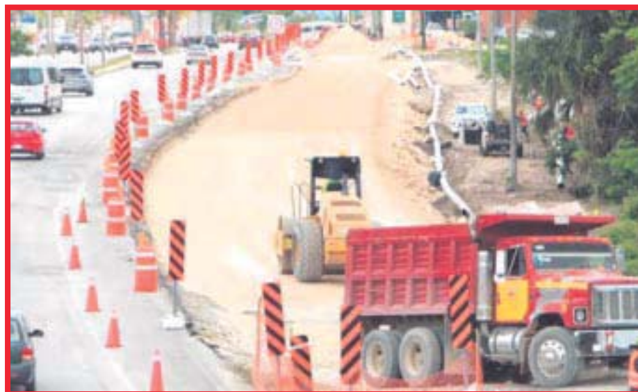
Esta semana iniciaron los trabajos de rehabilitación del primer tramo cuerpo "B" del Boulevard Luis Donaldo Colosio, en el sentido de Cancún-Playa del Carmen.
