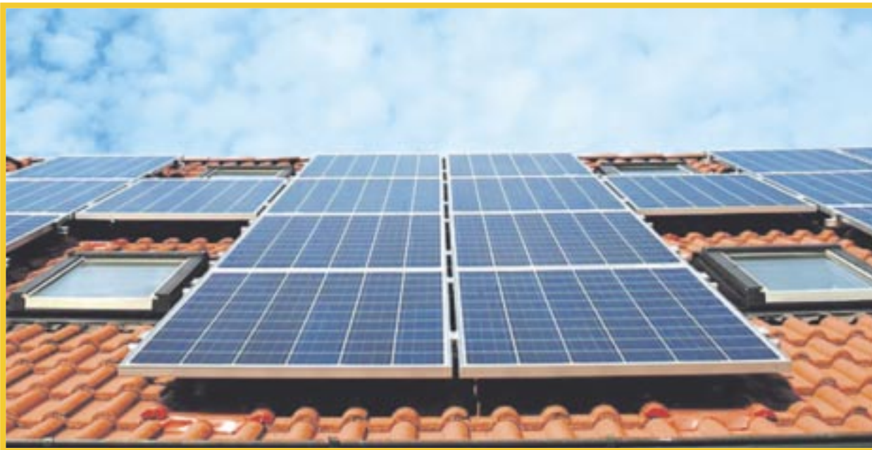
En el fraccionamiento Paraíso Maya arranca construcción del primer preescolar con energía sustentable.
