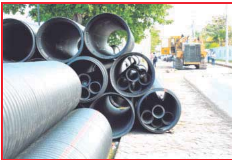
La CAPA inició la tercera etapa de la sustitución del colector de aguas residuales de la avenida “Rafael E. Melgar”.
