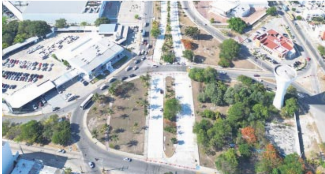
La obra del Boulevard Colosio , en Cancún, tiene más de 13 kilómetros de concreto hidráulico y un avance de más del 60%.
