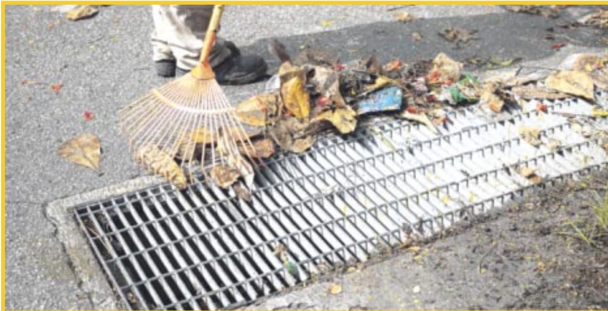
Refuerzan programa de limpieza para evitar encharcamientos en 24 colonias de Cozumel.
