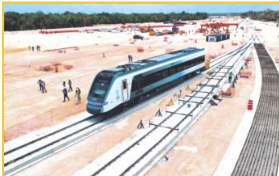
Los tramos 5 norte y sur, 6 y 7 del Tren Maya, estarán concluidos en febrero.
