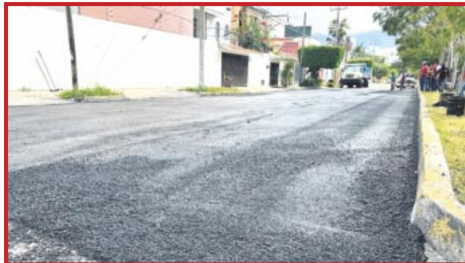
Constatan avance y calidad en las labores de mantenimiento y reparación de la carpeta asfáltica de la calle Chilam Balam en Cancún.
