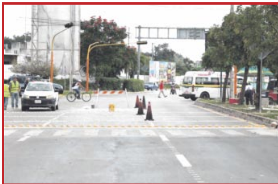
Avanzan obras que se están realizando en la Calle Págalo entre Av. Chac Mool y Av. Marabú en Cancún.
