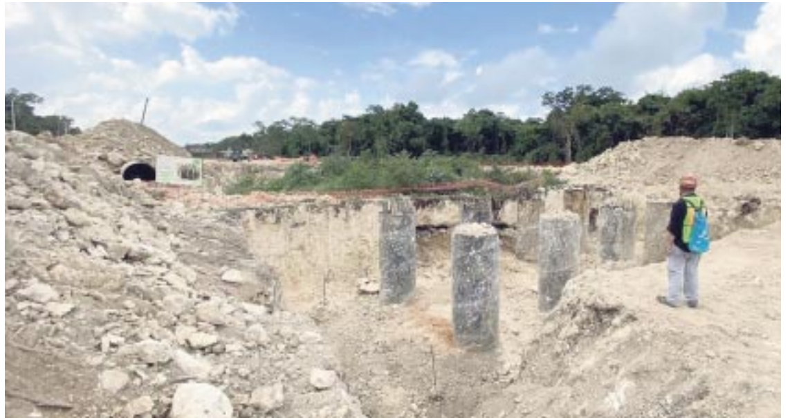
Un tribunal federal de Yucatán ordenó detener las obras del Tramo 5 Sur del Tren Maya.
