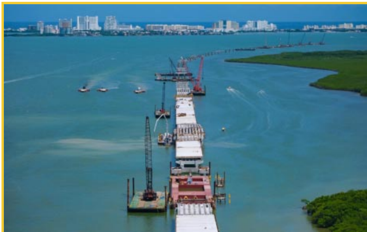
La gobernadora Mara Lezama señaló que el Puente Vehicular Nichupté será fundamental para mejorar la conectividad con la zona hotelera de Cancún; es una obra amigable con el medio ambiente porque contempla la protección de los manglares”.
