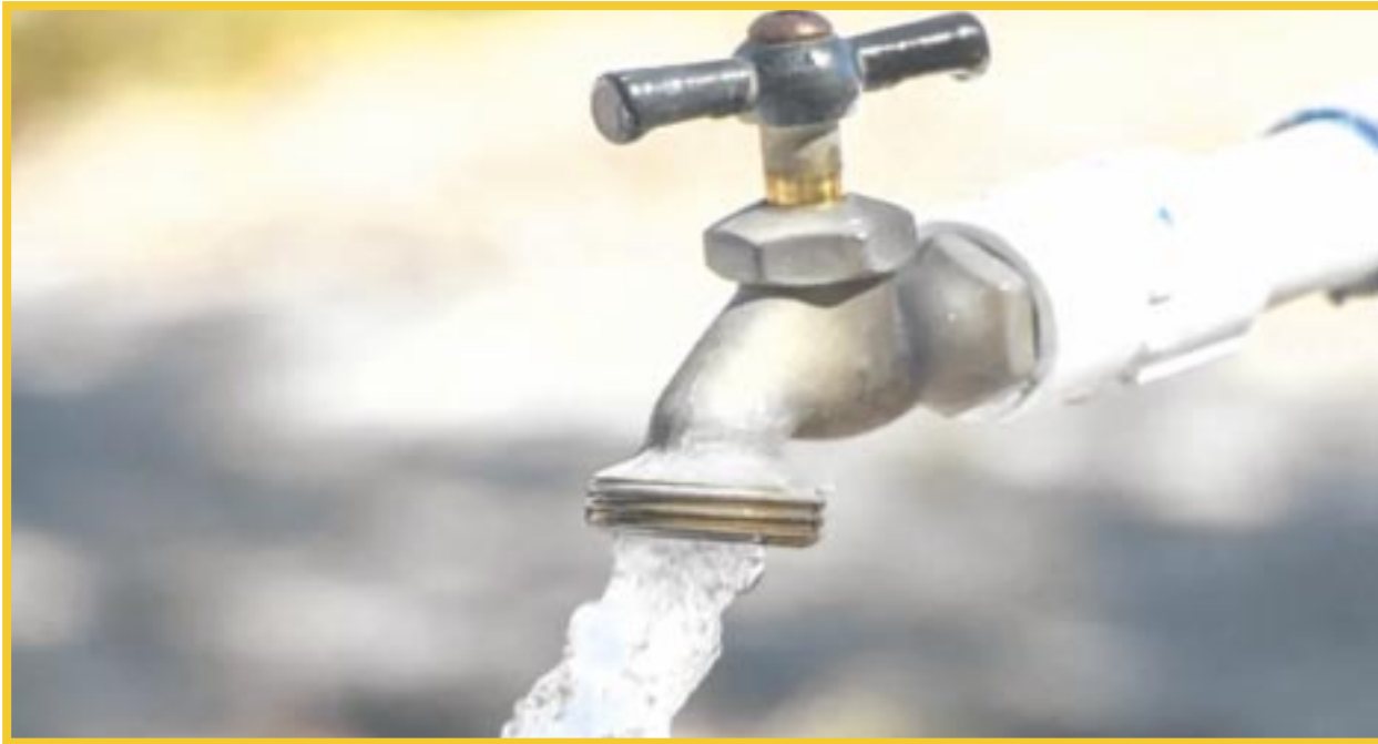
La capital de Quintana Roo, enfrenta una crisis de desabasto de agua que afecta a varias colonias de la ciudad.
