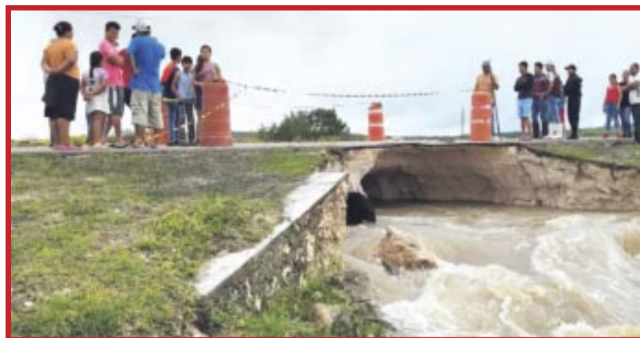
Instalan bocas de tormentas en vías de comunicación terrestre de 13 comunidades afectadas por la tormenta tropical “Nadine”.
