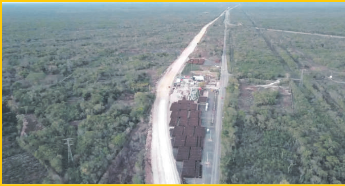
Expropian más terrenos en Lázaro Cárdenas y Felipe Carrillo Puerto para avanzar en la construcción del Proyecto Tren Maya.
